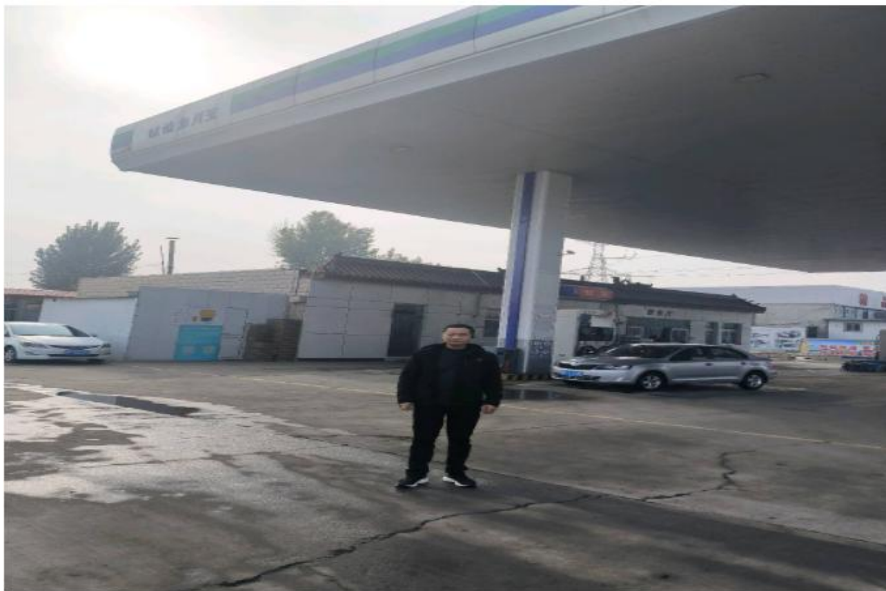
现场检测照片：
